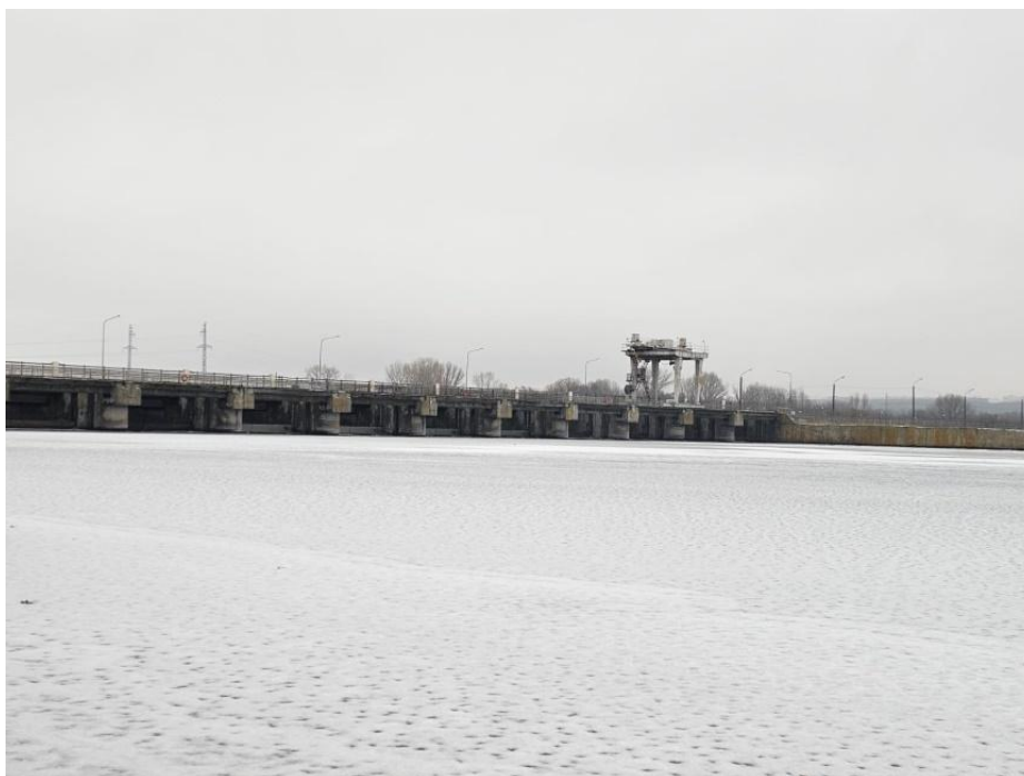
Рисунок 1. Гидротехническое сооружение, регулирующее объём водохранилища (фото авторов)
